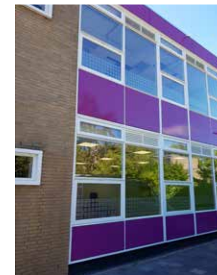
De toe- en afvoer van verse lucht vindt plaats via gevelroosters in de bestaande ramen.
